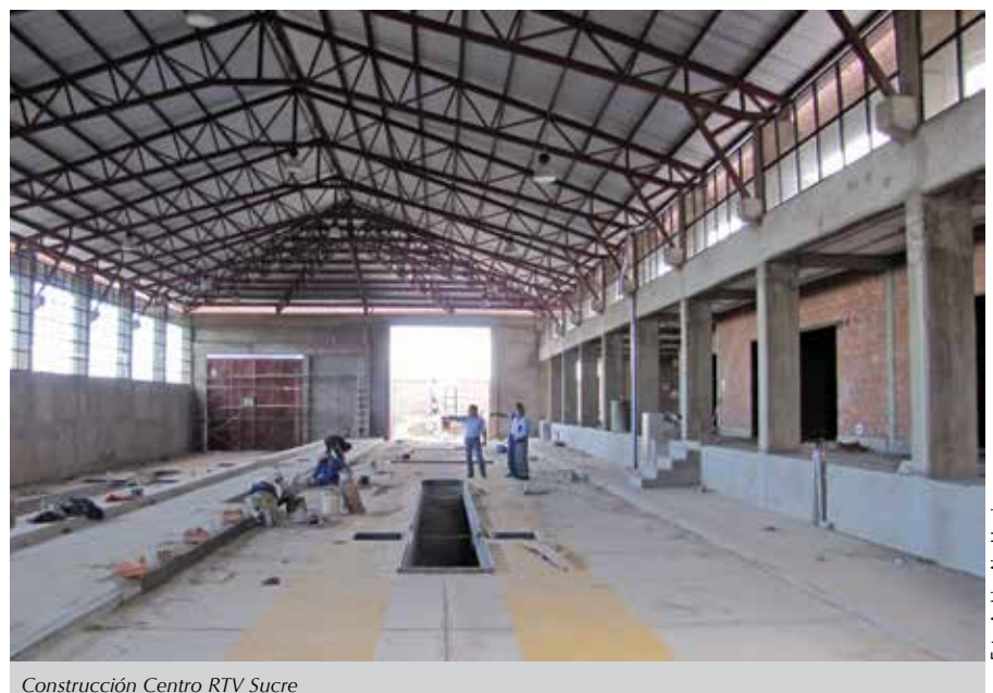
Construcción Centro RTV Sucre
