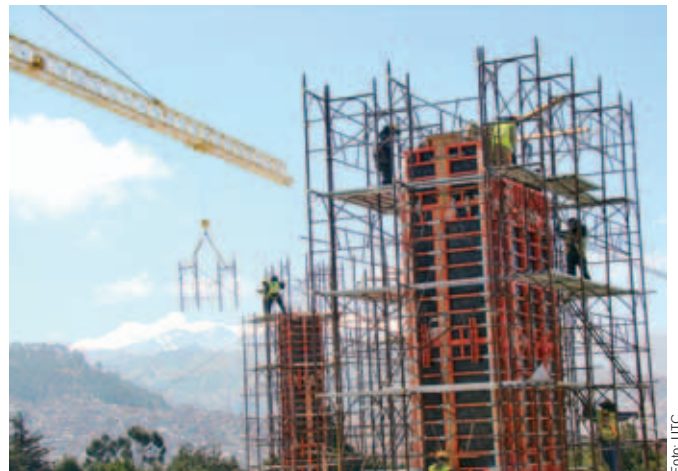
Construcción de una estación del teleférico.
