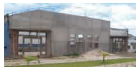
Centro de Inspección Técnica Vehicular en construcción en Santa Cruz.
