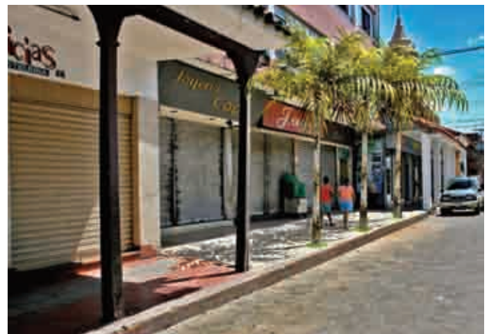
Proyectado de la reconstrucción de las aceras.
