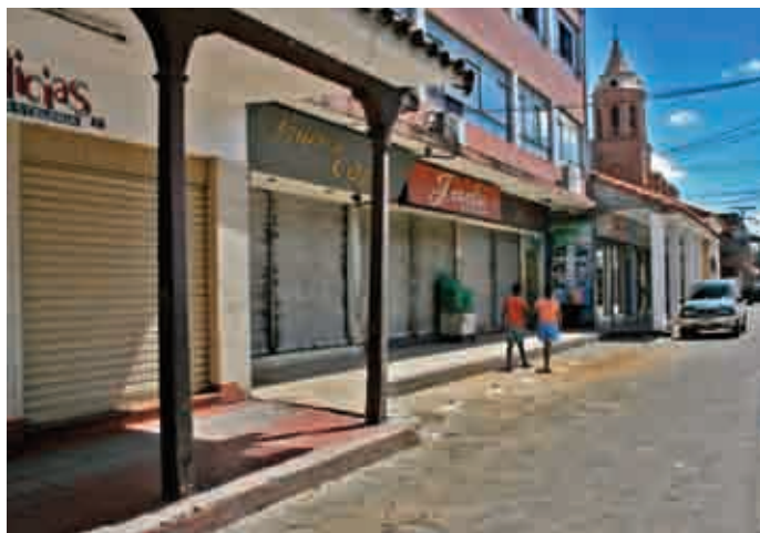
Estado actual de aceras.
