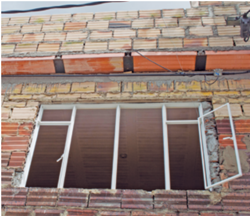
La placa fácil es el sistema de losa prefabricada más utilizada en la vivienda informal
