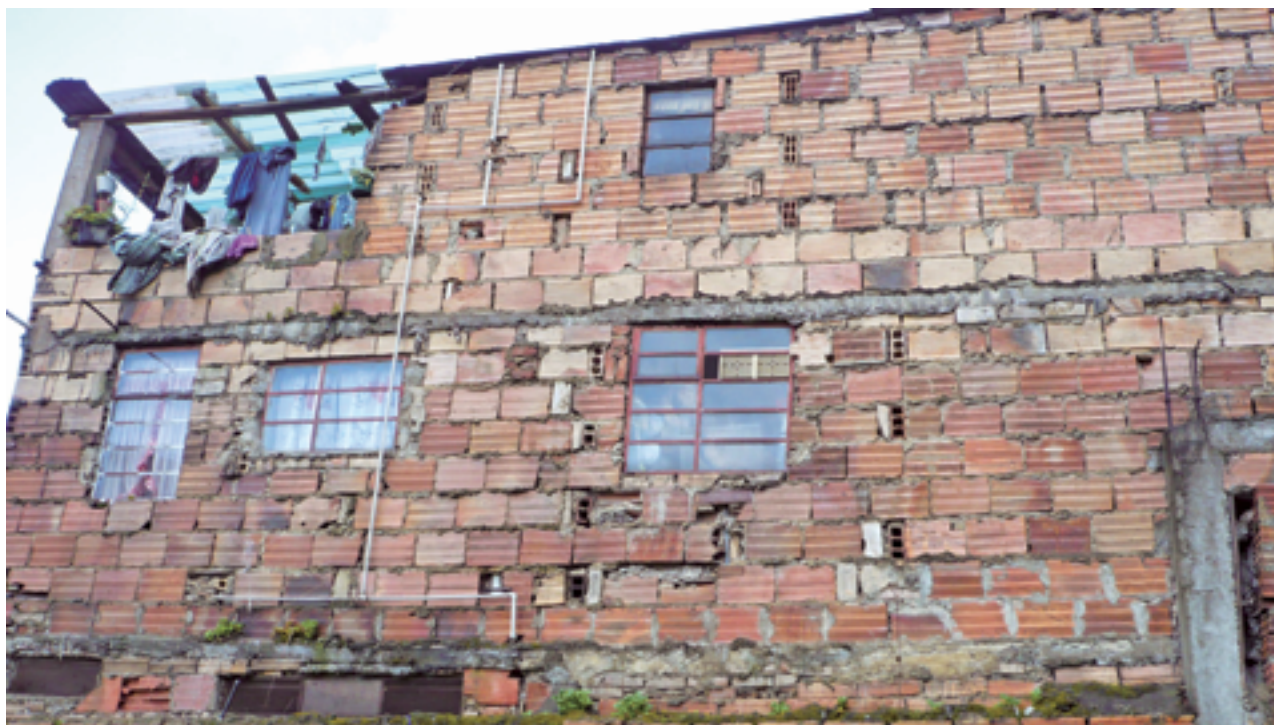
La unidad de mampostería predominante en vivienda informal es el bloque de arcilla de perforación horizontal
