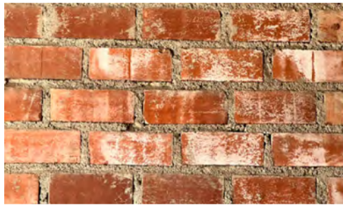
BP: Espesor del mortero de 1,5 a 2 cm*
