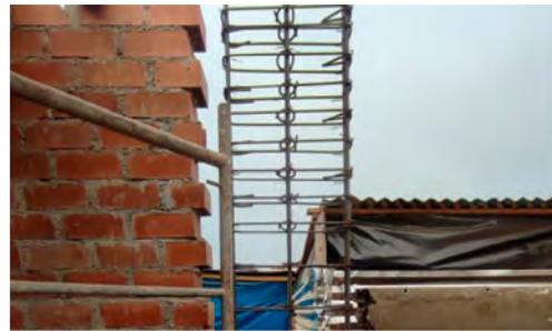
BP: Correcta distribución de estribos en columna*
