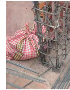
BP: Uso de anclaje químico en mechas de columnas*
