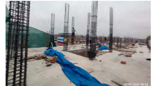
BP: Correcto recubrimiento para el acero en columnas*
