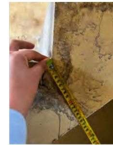
MP: Espesor de garganta menor de 15 cm / cangrejas en columnas*
