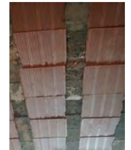
MP: Cangrejera en losa aligerada, viguetas*
