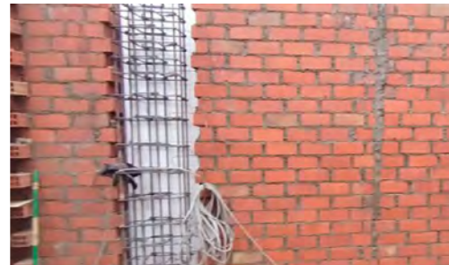
BP: Correcta distribución de estribos en las columnas y dentado en muro*
