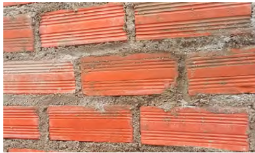
BP: Espesor del mortero de 1,5 a 2 cm*
