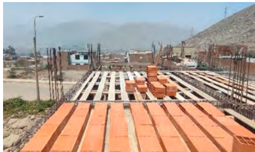
BP: Correcta longitud para empalmes de columnas*
