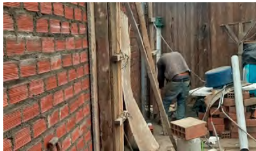
MP: Uso de ladrillo pandereta en muros portantes*
