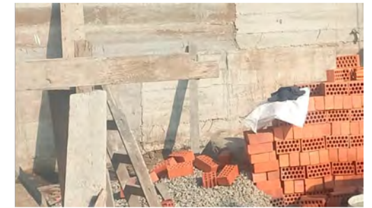
MP: Muro de contención sin cangrejas*
