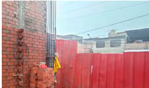
BP: Correcta longitud para empalmes de columnas*
