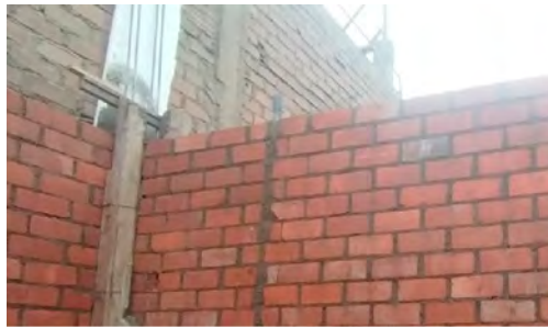
BP: Correcta longitud para traslapes en empalmes de columnas*
