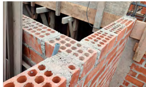
BP: Uso de ladrillo KK 18 H en muros portantes*
