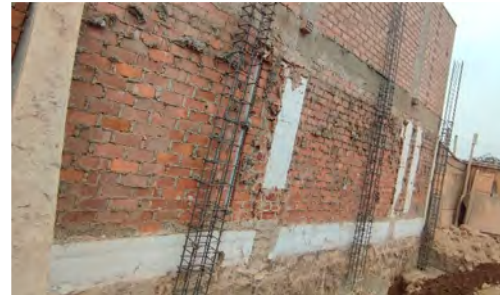
BP: Correcta distribución de estribos en las columnas*
