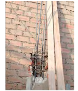
BP: Picado de columna para alcanzar la longitud de empalme necesaria*
