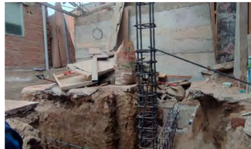
BP: Correcta distribución de estribos en las columnas y vigas de cimentación*
