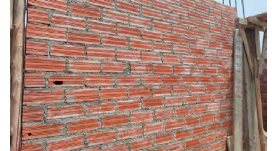
BP: Espesor del mortero de 1,5 a 2 cm*
