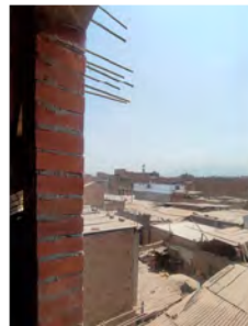
MP: Acero expuesto sin protección / longitud insuficiente para traslape de columnas*
