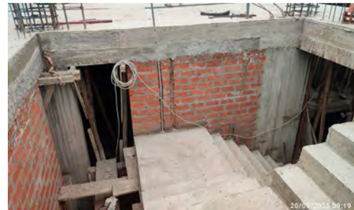
MP: Estructura aporricada, se encuentra confinada por la viga*
