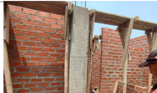
BP: Columnas con mínimas presencia de cangrejas*
