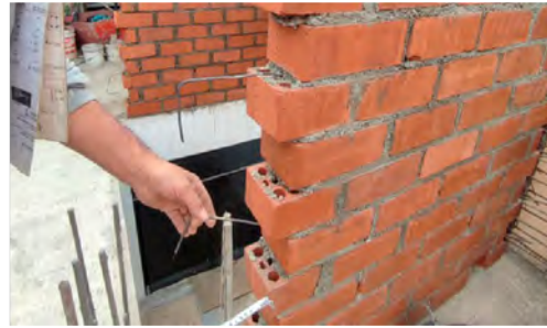
BP: Dentado en muros de 5 cm, uso de mechas*
