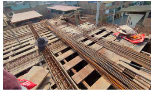
BP: Correcta distribución de estribos*
