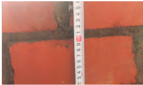
BP: Espesor del mortero de 1,5 a 2 cm*
