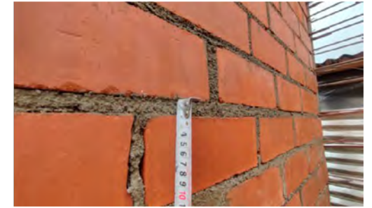
BP: Espesor del mortero de 1,5 a 2 cm*
