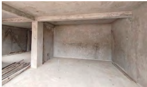
BP: Vigas peraltadas en ambas direcciones*
