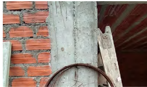
MP: Incorrecto dentado en muro.*
