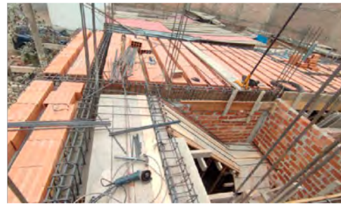
BP: Descanso de escalera de loza maciza*
