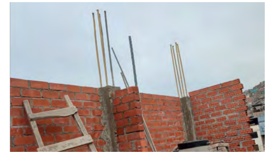
BP: Correcta longitud para traslapes en empalmes de columnas*
