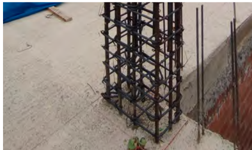
BP: Correcto recubrimiento para el acero en columnas*
