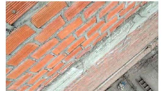
MP: Muro portantes con ladrillo pandereta (5to nivel)*
