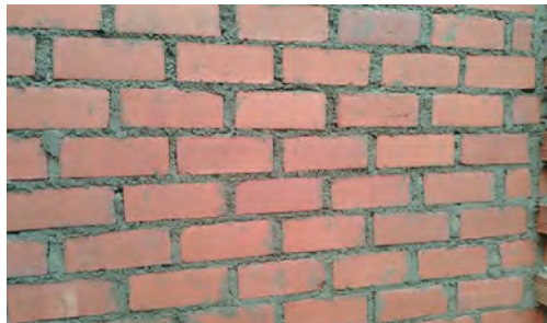
BP: Juntas del mortero no mayor a 1,5 - 2 cm*
