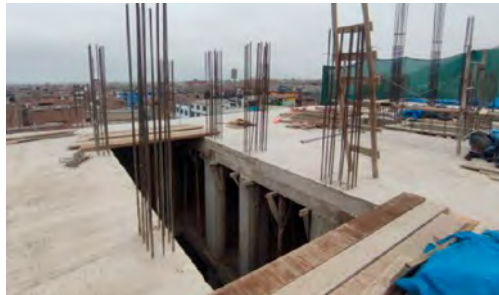
BP: Correcta longitud para traslapes en empalmes de columnas*
