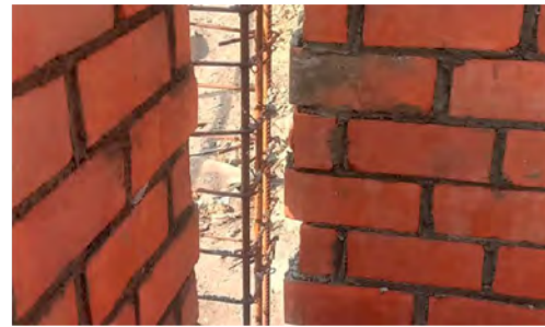
BP: Dentadas de 5 cm en muro*
