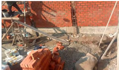
BP: Uso de ladrillo kk 18h*
