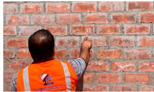
BP: Espesor del mortero de 1,5 a 2 cm*
