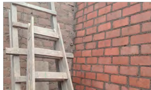
MP: Juntas del mortero de 1,5 a 2 cm*
