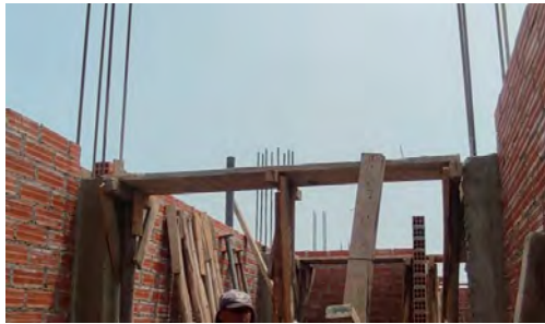
BP: Correcta longitud de empalme en columnas*
