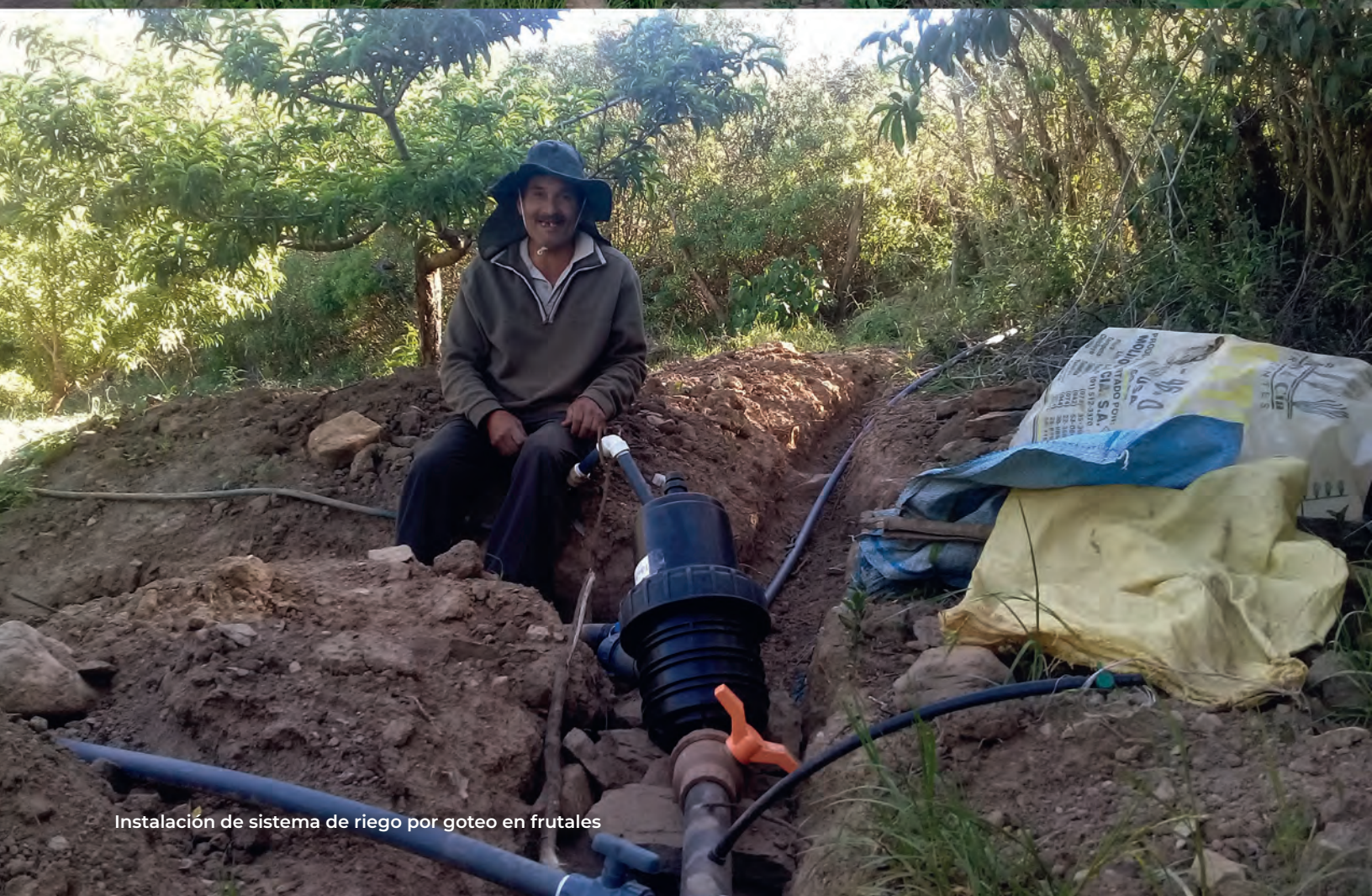
Cabezal de sistema de riego por goteo para huerto frutal
