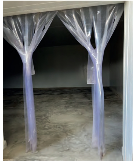
Foto 10.25. Portón de ingreso y cortina de la cámara de frío, FRUTA DE MI TIERRA – Vallegrande (gentileza Diego Gutiérrez).
