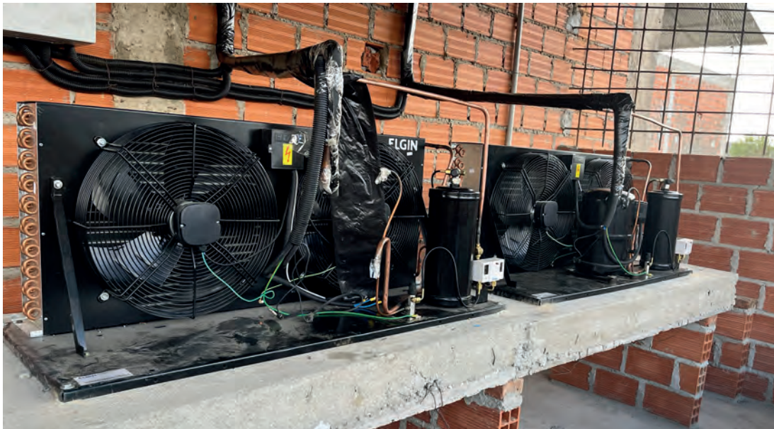
Foto 10.26. Sala de máquinas de cámara frigorífica, FRUTA DE MI TIERRA – Vallegrande (gentileza Mario Rocabado).
