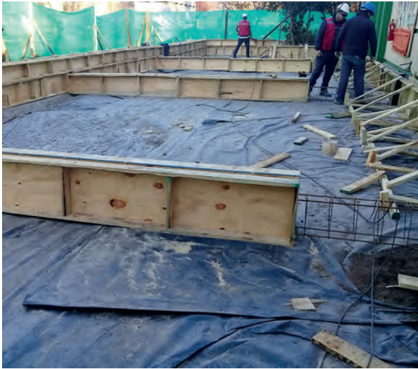
Foto 10.24. Aislamiento del piso para una cámara frigorífica.
