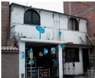
FACHADA DE LA VIVIENDA
