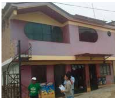
FACHADA DE LA VIVIENDA
