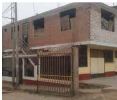
FACHADA DE LA VIVIENDA
