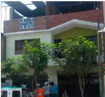
FACHADA DE LA VIVIENDA
