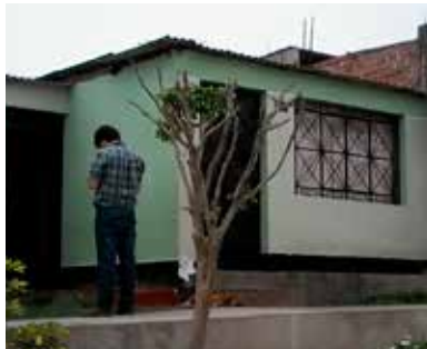
FACHADA DE LA VIVIENDA
