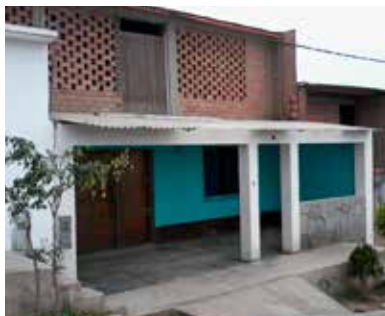
FACHADA DE LA VIVIENDA
