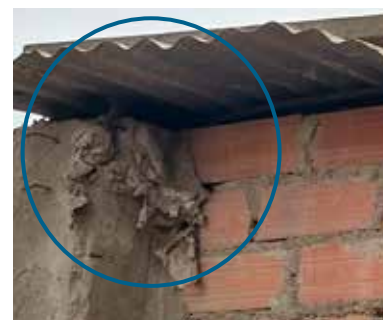
MUROS PORTANTES SIN CONFINAMIENTO SUPERIOR
