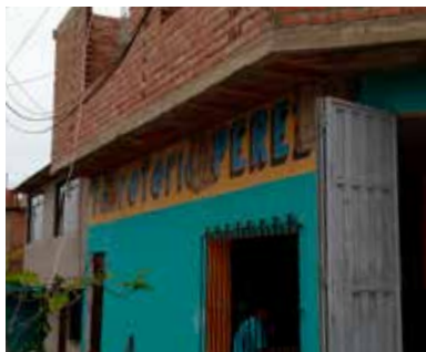
FACHADA DE LA VIVIENDA
