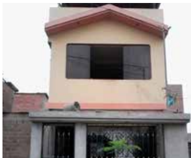
FACHADA DE LA VIVIENDA
