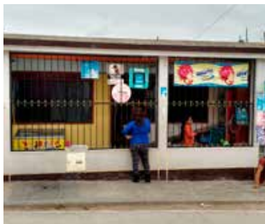
FACHADA DE LA VIVIENDA
