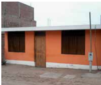
FACHADA DE LA VIVIENDA
