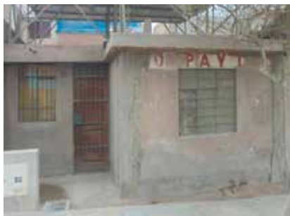
FACHADA DE LA VIVIENDA
