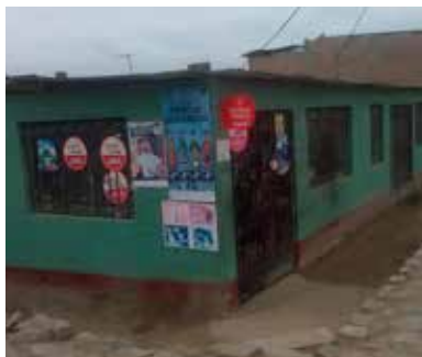
FACHADA DE LA VIVIENDA
