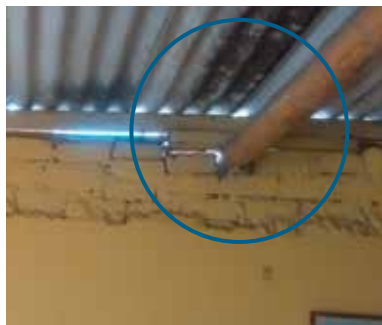
MUROS PORTANTES SIN CONFINAMIENTO
