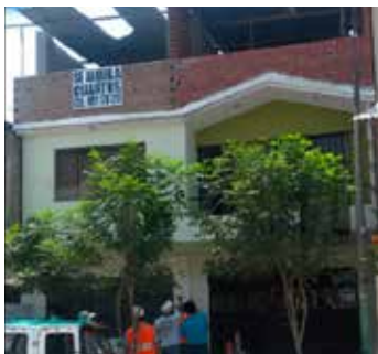
FACHADA DE LA VIVIENDA
