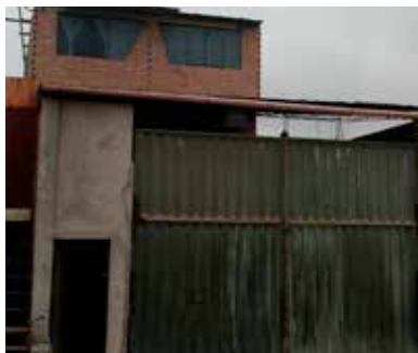
FACHADA DE LA VIVIENDA
