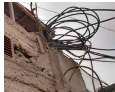
CABLES EXPUESTOS
