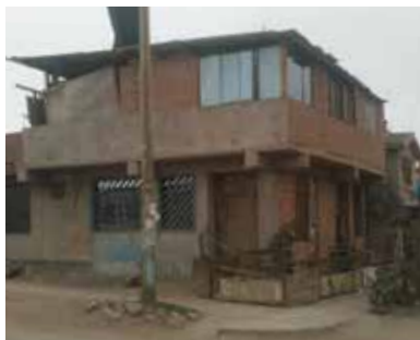
FACHADA DE LA VIVIENDA
