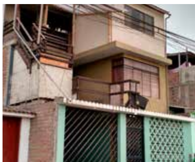
FACHADA DE LA VIVIENDA
