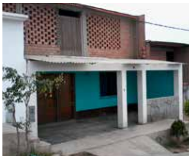
FACHADA DE LA VIVIENDA
