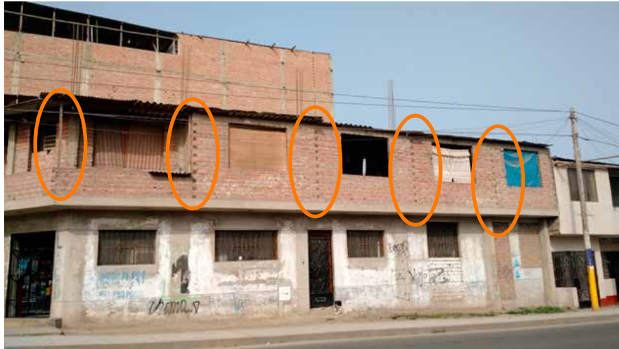
(Fuente: SWISSCONTACT - Levantamiento de información físico espacial de la vivienda)
