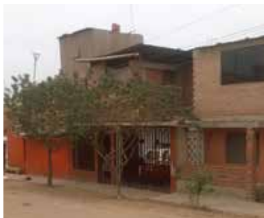
FACHADA DE LA VIVIENDA
