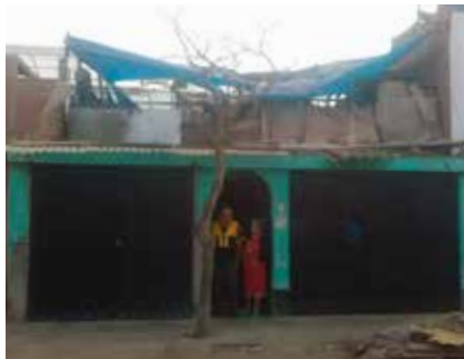
FACHADA DE LA VIVIENDA
