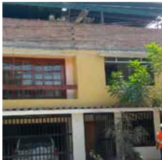
FACHADA DE LA VIVIENDA
