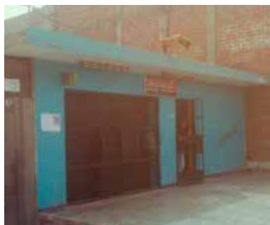
FACHADA DE LA VIVIENDA
