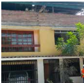
FACHADA DE LA VIVIENDA
