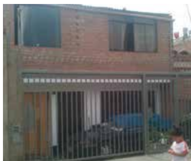
FACHADA DE LA VIVIENDA
