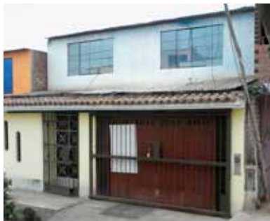
FACHADA DE LA VIVIENDA
