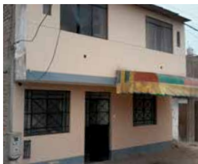
FACHADA DE LA VIVIENDA
