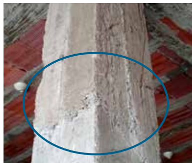
JUNTA FRÍA EN COLUMNA CENTRAL
