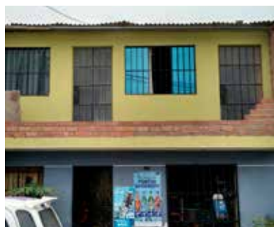
FACHADA DE LA VIVIENDA
