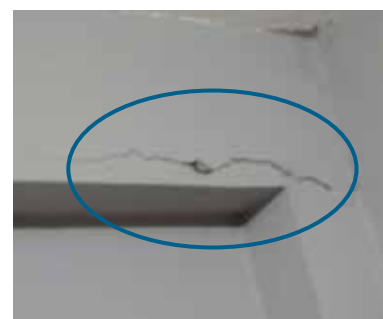
VIGA AGRIETADA
