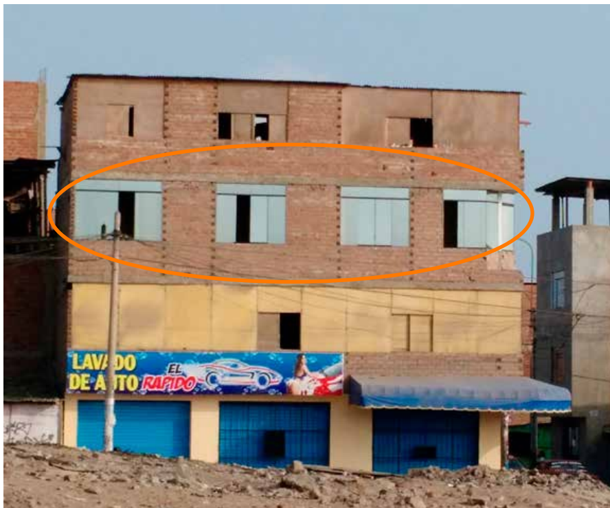
(Fuente: SWISSCONTACT - Levantamiento de información físico espacial de la vivienda)
