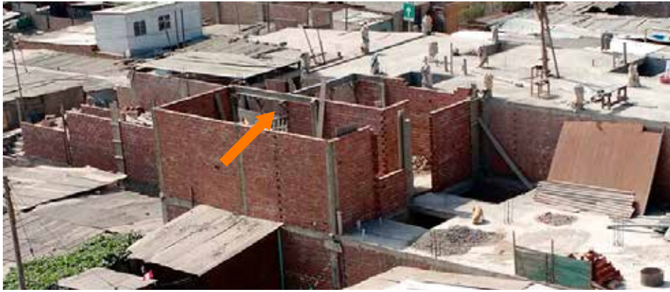
(Fuente: SWISSCONTACT - Levantamiento de información físico espacial de la vivienda)
