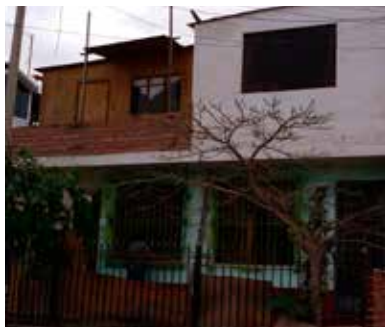
FACHADA DE LA VIVIENDA
