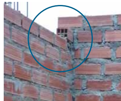
MUROS SIN CONFINAMIENTO
