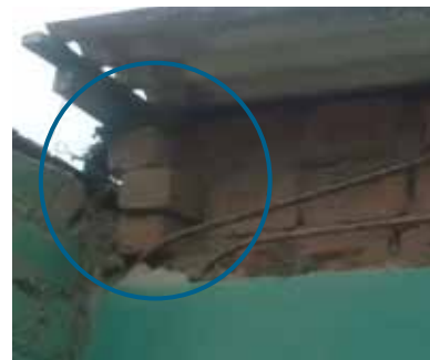
EXPOSICIÓN DEL ACERO DE REFUERZO
