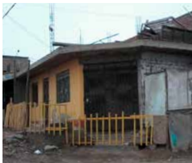
FACHADA DE LA VIVIENDA
