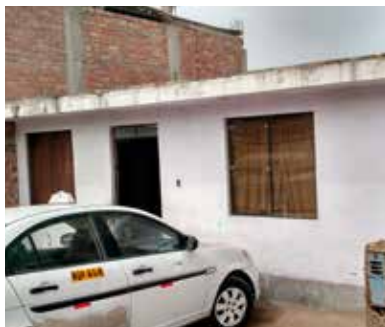
FACHADA DE LA VIVIENDA
