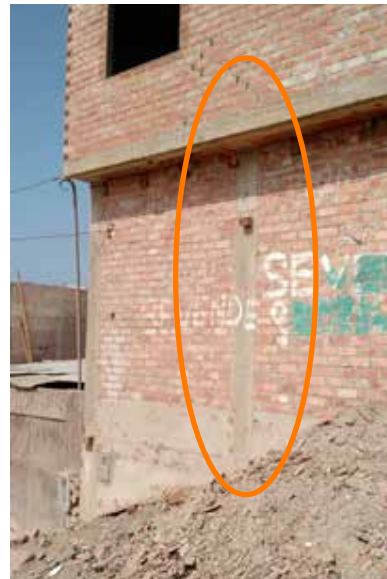
(Fuente: SWISSCONTACT - Levantamiento de información físico espacial de la vivienda)
