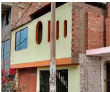
FACHADA DE LA VIVIENDA
