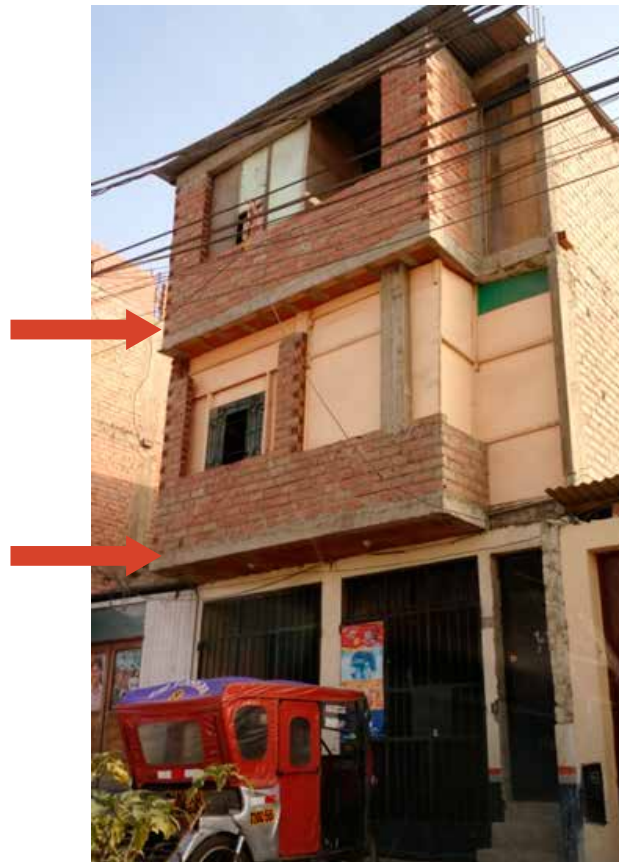
(Fuente: SWISSCONTACT - Levantamiento de información físico espacial de la vivienda)
