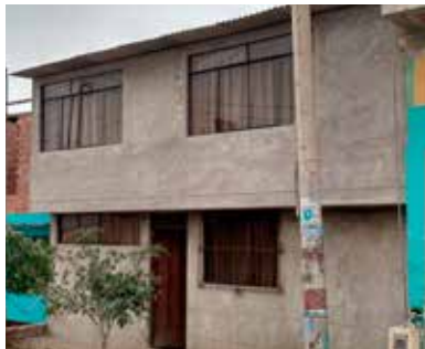
FACHADA DE LA VIVIENDA
