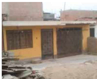
FACHADA DE LA VIVIENDA
